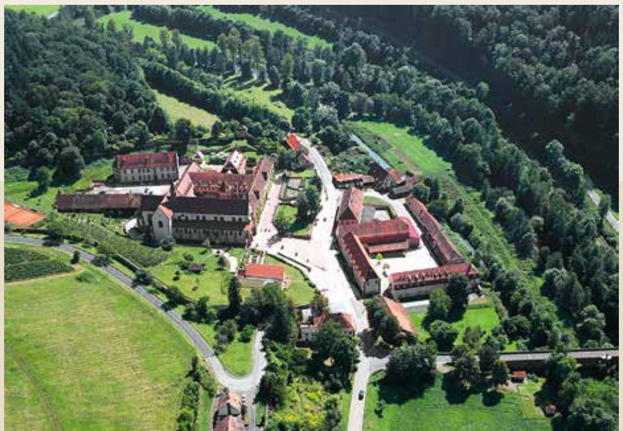
Luftaufnahme des Klosters Bronnbach
