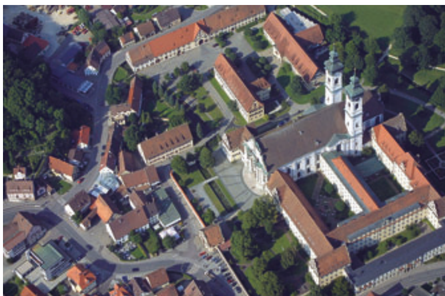
Luftaufnahme des Münsters Zwiefalten
