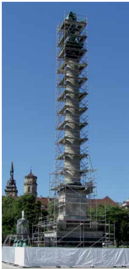
Eingerüstet: die Stuttgarter Jubiläumssäule
