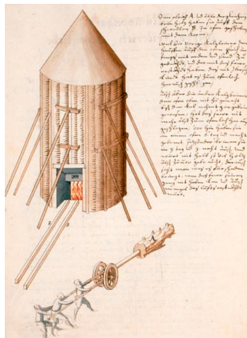
Technik des Kalkbrennens um 1600. Kolorierte Federzeichnung Schickhardts. In Montbéliard hatte Schickhardt Kalköfen entdeckt, die er mit einer Verbesserung zur Senkung des Holzverbrauchs nachbaute. Die Öfen konnten an dem Ort aufgestellt werden, wo der gebrannte Kalk gebraucht wurde. Anwendung fanden die mobilen Öfen zum Beispiel beim Bau des Boller Bades.
