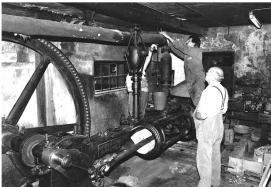
Ausbau der Dampfmaschine im Untergeschoss der Sägerei Bertsch in Kohlstetten.
