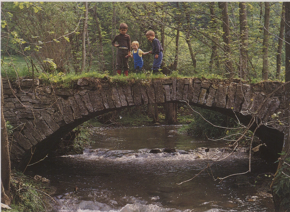
Am Buchenbach bei Affalterbach gibt es noch sieben solcher Gewölbebrücken.
