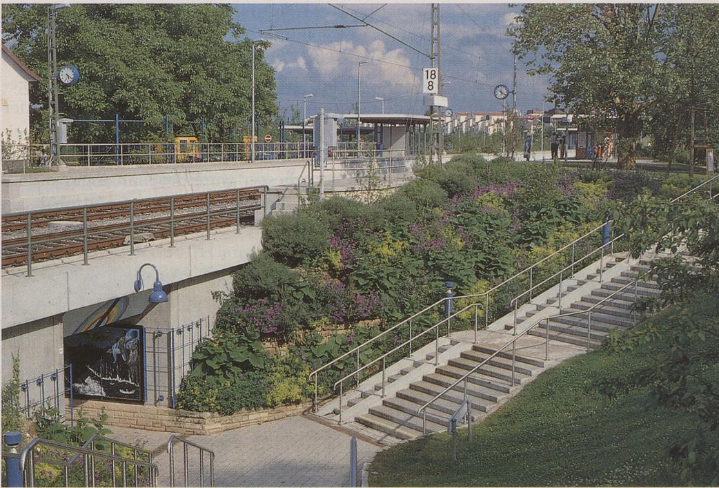
Bei der Unterführung am Oberaichener Bahnhof ist der übliche kellerartige, durch Betonmauern abgestützte Abgang durch eine Ausmuldung ersetzt worden. Dort ist durch landschaftlich-gärtnerische Gestaltung anstelle eines nur funktionsgerecht geplanten technischen Bauwerks an einer von vielen begangenen Stelle eine helle und freundliche Anlage entstanden.
