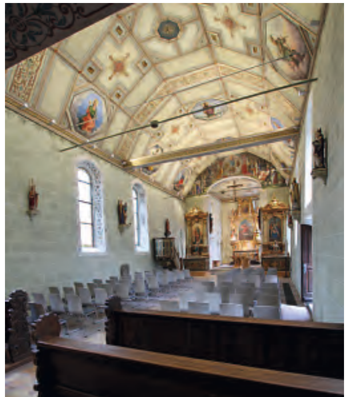
Martinskirche, Blick nach Osten. Die «sargdeckelartige» Decke stammt noch aus dem 16. Jahrhundert und wurde bei der Renovierung in regelmäßige geometrische Felder eingeteilt. Dann wurden die von Jakob Baur auf Leinwand gemalten Notthelfer eingefügt.
