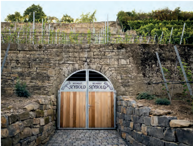
Mit dem restaurierten Eingangsbereich und einem Holztor ist der Keller heute ein Aushängeschild für das Weingut Seybold.
