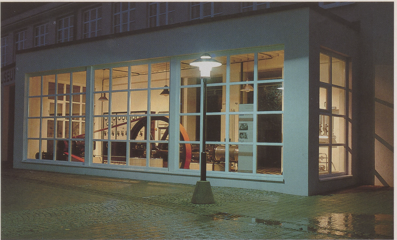
Fassadenvorbau des Maschenmuseums, der eine funktionsfähige Dampfmaschine beherbergt, die mehr als 40 Jahre lang den Strom für eine Albstädter Textilfirma erzeugte. Hergestellt von der Reutlinger Maschinenfabrik Ulrich Kohlöffel, Baujahr 1942, max. Leistung 110 PS, Generator 84 kW, 200 Umdrehungen/Minute, Gewicht 4,2 t.
