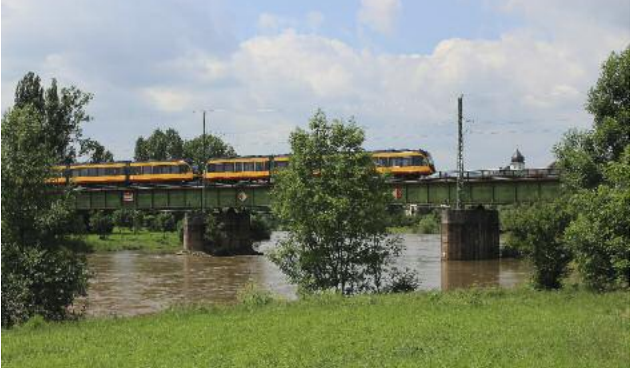
Von Sinsheim kommender Stadtbahnzug S 42 auf der Brücke (mit Fuß- und Radweg!) über den hochwasserführenden Neckar bei Bad Friedrichshall-Jagstfeld. Der Wendelinusurm von Jagstfeld ist gerade noch zu sehen.
