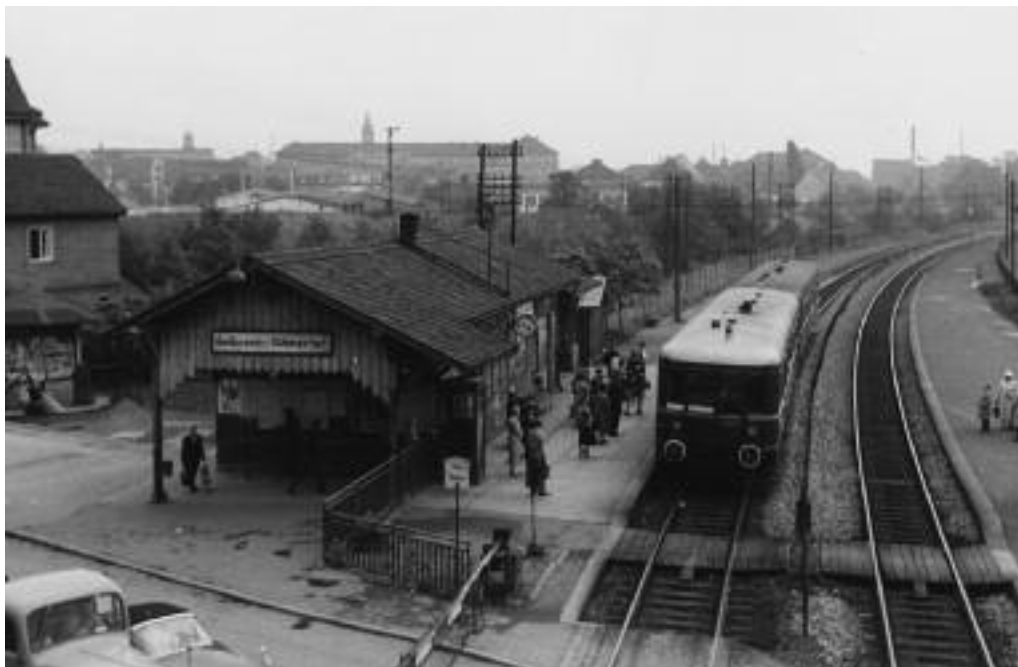
Der Bahnhof Heilbronn-Sülmertor mit beschränktem Bahnübergang im Jahr 1957, vom Fußgängersteg aus. Es hält ein Dieseltriebwagen der Vorkriegsbauart VT 60 mit Steuerwagen VS 145. Links war die Endstation der Straßenbahn. Nach langem Für und Wider entschied sich der Heilbronner Gemeinderat hier für eine Unterführung der Stadtbahn. Im Hintergrund der Hafemarktsturm und der Turm der Kilianskirche.
