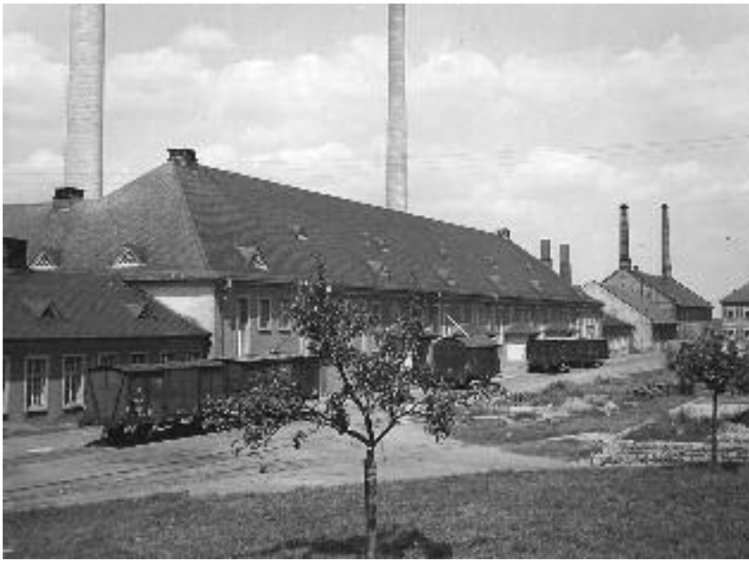
Ludwigs-Saline in Bad Rappenau, 1960. Blick auf nördliches Siedehaus mit Salzmagazin, davor Güterwagen. Im Innenhof gab es sechs Abstell- und Rangiergleise und drei Drehscheiben, die den regen Güterverkehr auf Schienen belegen.
