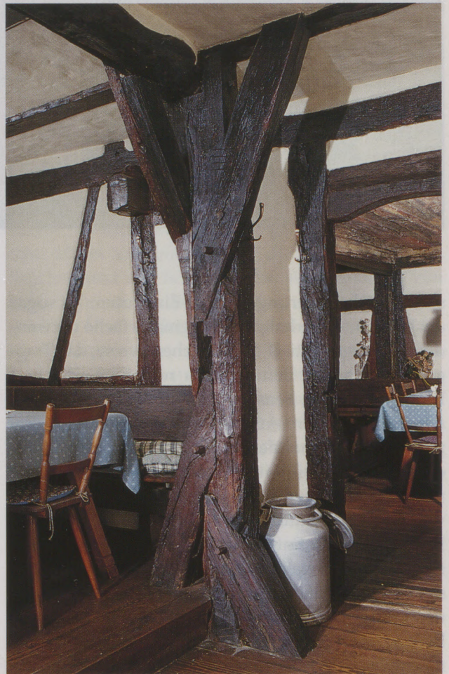
Fachwerkhaus in Mühlacker-Lienzingen: verblattete Holzkonstruktion.
