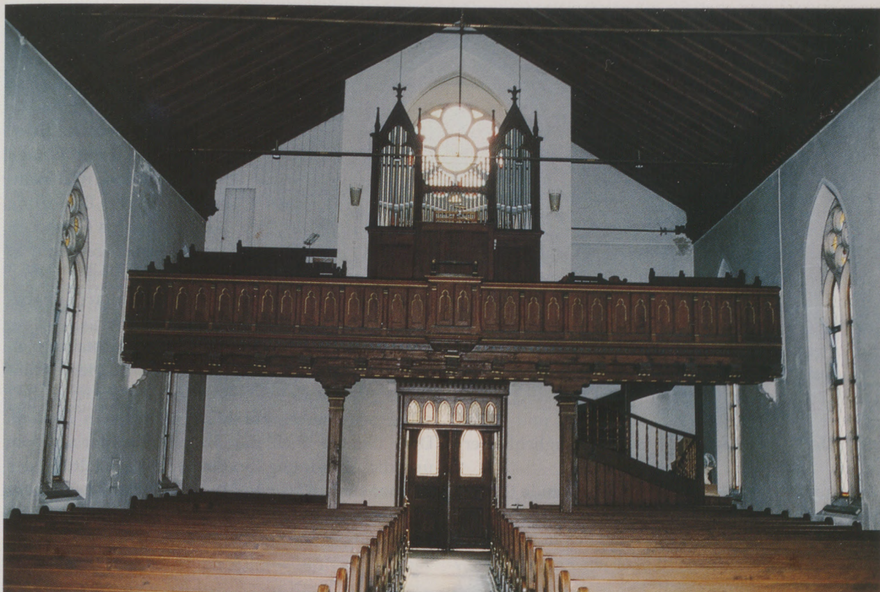
Kircheninneres – Blick nach Süden. Man sieht die zeltförmig angeordnete Holzdecke mit ihren Querstangen, ein typisches Merkmal der Dolmetsch-Kirchen. Flecken im Verputz stammen von Wassereinbrüchen am Südgiebel.
