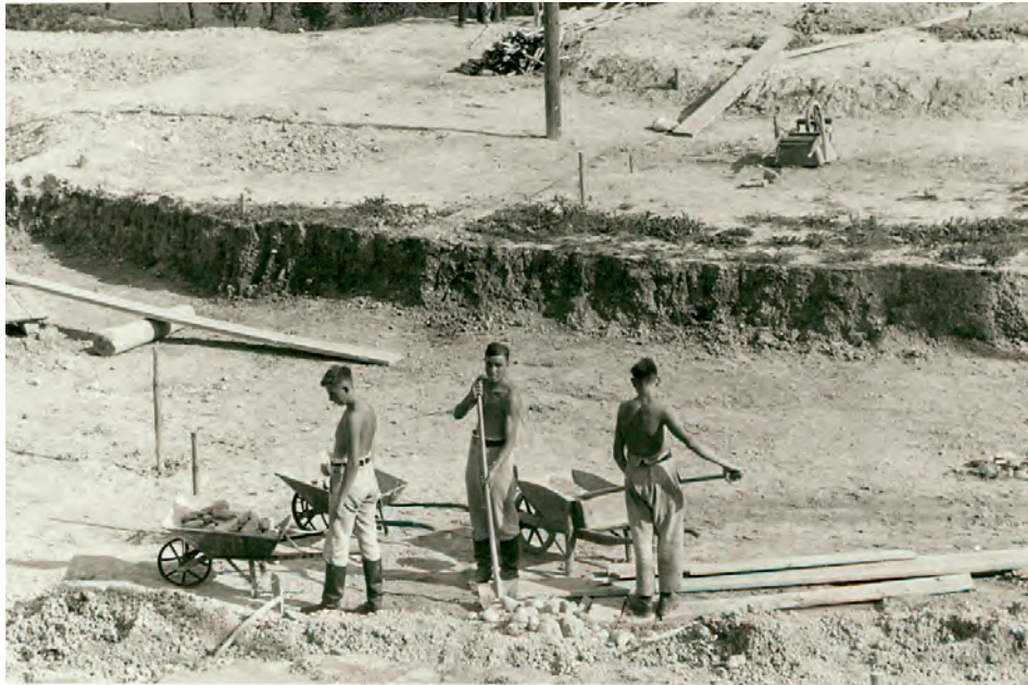
Bauarbeiten im Sommer 1937
