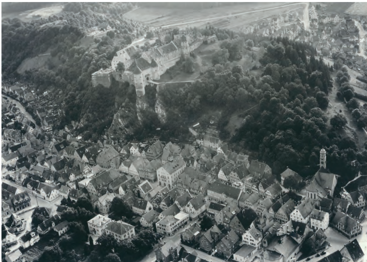
Das helle Rund am oberen Bildrand links zeigt die Baustelle auf dem Schlossberg, 55 Meter über der Stadt gelegen. Heute befindet sich dort eine Sportanlage.
