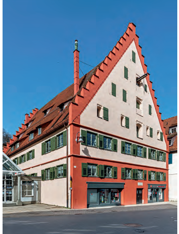
Der stattliche Bau des ehemaligen Salzstadels mit seinem hohen Treppengiebel ist ein aussagekräftiges Zeugnis der Reichsstadtvergangenheit von Biberach geblieben.
