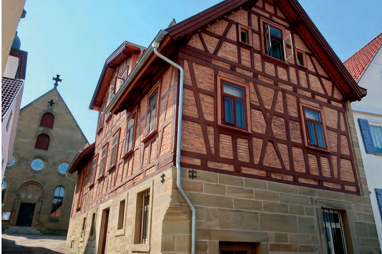
Nach Leerstand und Verwahrlosung zeigt sich das Fachwerkhaus nach der Sanierung auch von der Talseite wieder als Blickfang.
