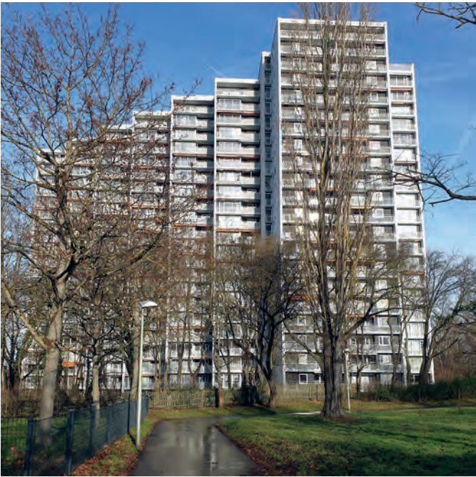
Die drei 20-stöckigen Hochhäuser im Fasanenpark – Fasan I, II und Salute – waren für annähernd 10.000 Menschen geplant.
