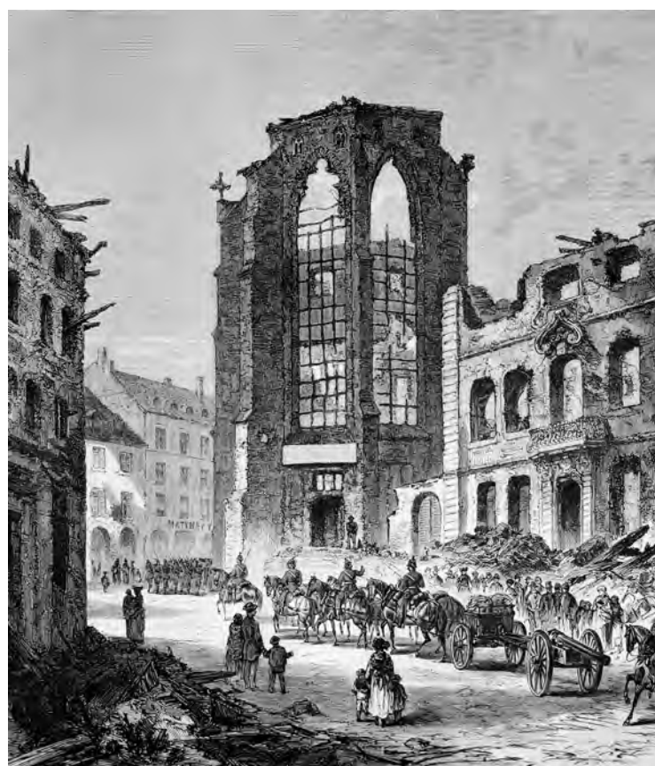
Die Ruine des Temple Neuf, der ehemalige Dominikanerkirche, in dem 1870 die Straßburger Stadtbibliothek und darin die wertvolle Sammlung mittelalterlicher Handschriften verbrannte. Der Stich entstammt einer illustrierten Kriesschronik von 1870/71.
