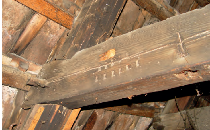
An den Sparren geblatteter, mit Abbundzeichen markierter Kehlbalken über dem zweiten Dachgeschoss. Die hier verwendete, im Frühsommer 1494 geschlagene Fichte stammt laut des am rechten Bildrand sichtbaren «Floßauges» aus dem Schwarzwald und wurde auf dem Neckar nach Tübingen gefloßt. «Floßaugen» nennt man die schwarzwalddtypische Form der «Wiedlöcher» zum Durchführen der Wieden beim Zusammenbinden der Stämme zum Floß.
