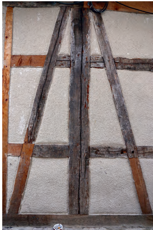
Original erhaltene verzapfte Gerüstaussteifung von 1495 mit eng am Bundständer anliegenden Feldstreben in der westlichen Traufwand.
