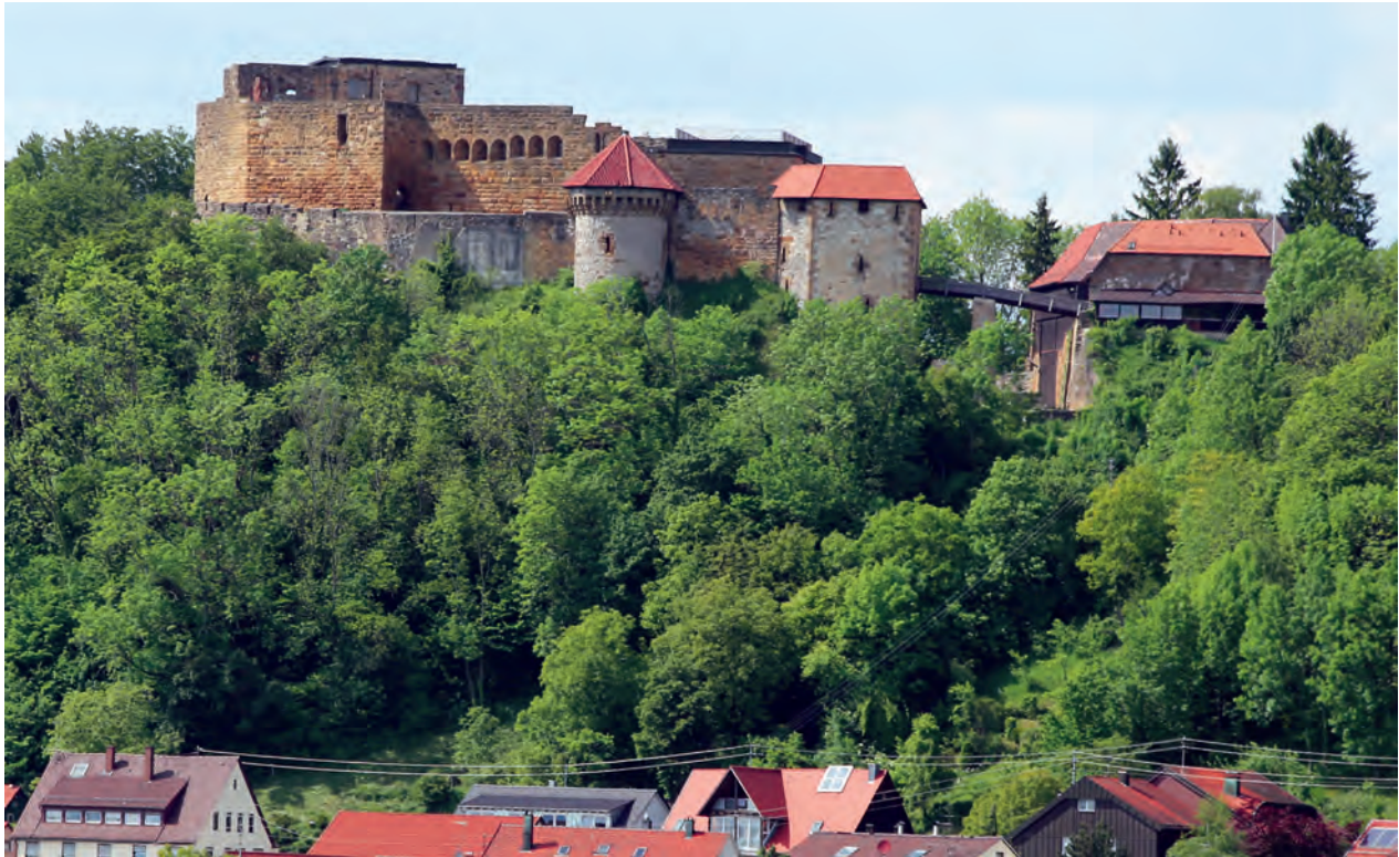
Die Burg Rechberg, genannt Hohenrechberg, von Süden. Der auf Höhe der Grabensohle liegende «Äußere Zwinger» ist von Bewuchs verdeckt.
