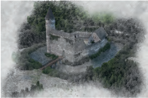
Als Keimzelle des heutigen Schlossensembles ist eine frühmittelalterliche Wasserburg anzunehmen, Sitz der Herrschaft mit Ringmauer, Bergfried und Palas.
