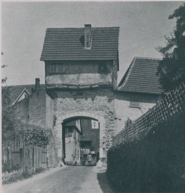
Torturm von Gemmrigheim. Mit Rücksicht auf die Erfordernisse des Berufsverkehrs mußte das bisherige Spitzbogentor verändert werden, doch gelang es auf diese Weise, das reizende Straßenbild zu erhalten. Neben einem Beitrag des Landesamts für Denkmalpflege hat auch der Schwäbische Heimatbund einen Beitrag zur Rettung des Tores gegeben.
