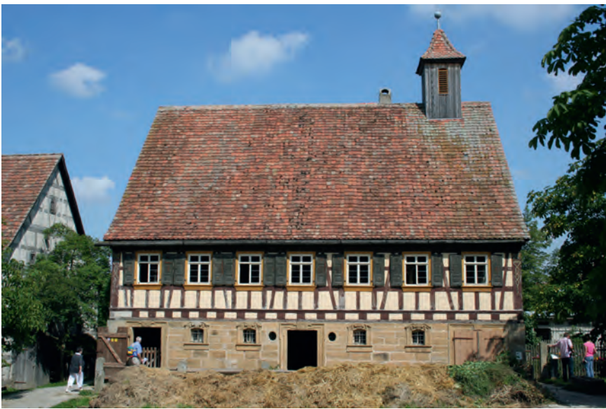
Das Haus Frank, erbaut 1794 in Elzhausen, Gemeinde Braunsbach, 1979/80 ins Hohenloher Freilandmuseum Wackershofen transloziert. Bis heute prägt der Typ des mittelgroßen «gestelzten Wohn-/Stall-Hauses» mit Bauschmuck an Sandsteinsockel, Eckpfosten und Giebel das Ortsbild zahlreicher Weiler und Dörfer in Hohenlohe.
