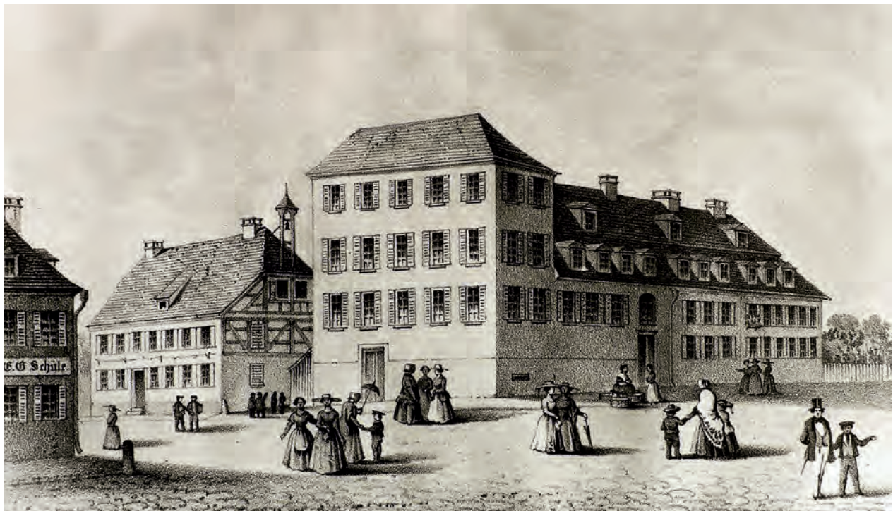
Das sogenannte «Töchterinstitut» in Korntal beherbergte ein Schülerinnenwohnheim, eine höhere Mädchenschule sowie eine Haushalts- und Frauenarbeitsschule. Wegen des schlechten Baugrunds aus Gipskeuper wurde es baufällig und musste in den 1950er-Jahren abgerissen werden. Heute steht an seiner Stelle das Korntaler Rathaus. Lithographie von A[dam] Gatternicht, Stuttgart, gezeichnet von O. Kolb, nach 1863.
