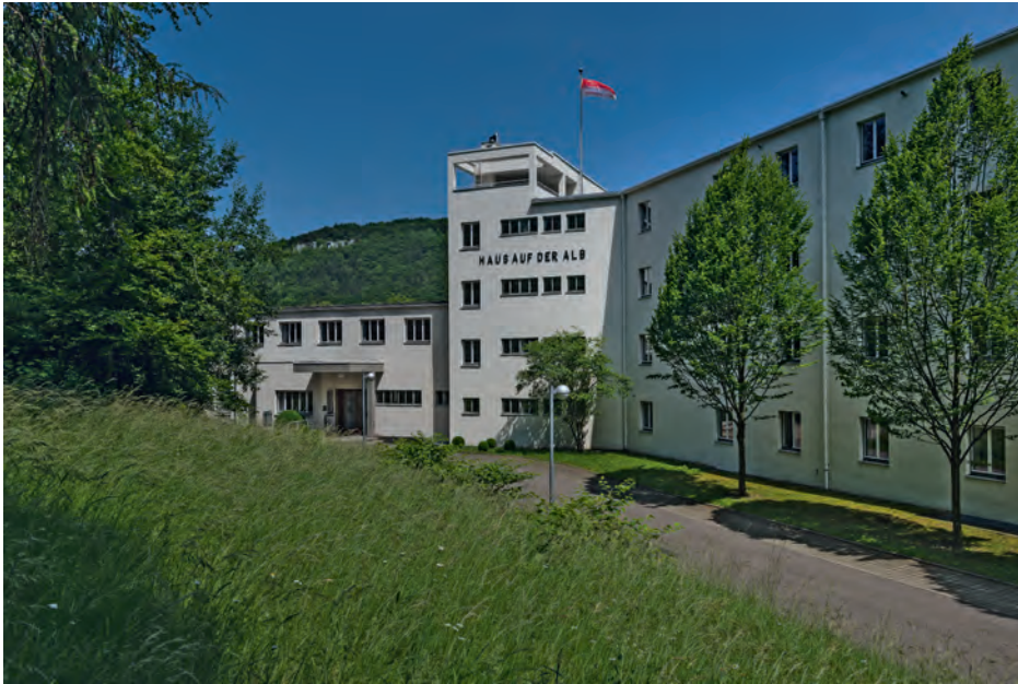
Von der Zufahrt aus südwestlicher Richtung liegt der Turm mit dem Namen und der Eingang im Blick.
