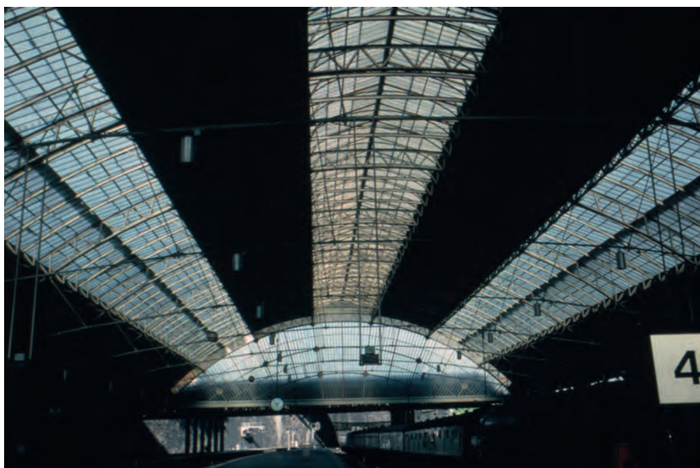
Die moderne Ingenieurtechnik zeigt sich im Innern: Halle der Central Station in Glasgow, ca. 1900.
