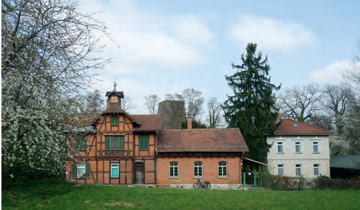
Das Garnisonsschützenhaus 2017. Im Hintergrund der Abluftkamin des Heselacher Tunnels.
