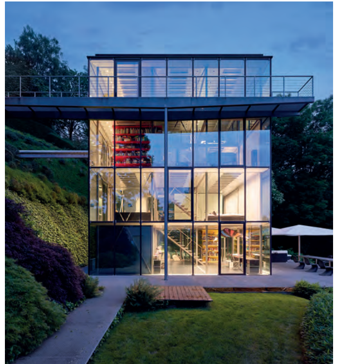
Werner Sobeks eigenes Wohnhaus R 128 am Rand des Stuttgarter Talkessels folgt der Triple-Zero-Philosophie: kein Energiebedarf, der nicht vom Gebäude aus nachhaltigen Quellen selbst erzeugt werden kann, keine klimaschädlichen Emissionen, keine Abfälle. Das heißt: alle Bauteile sind wiederverwendbar.
