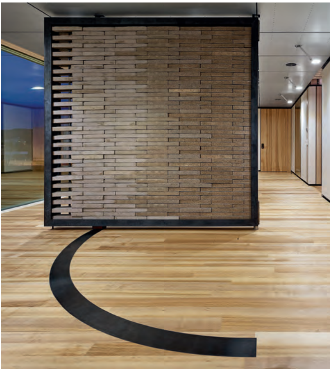
Die Steine dieser schwenkbaren Wand bestehen aus aufgearbeitetem mineralischem Bauschutt. Sie gehören zur Wohneinheit »Urban Mining and Recycling« (UMAR) im Forschungsgebäude »Next Evolution in Sustainable Building Technologies« (NEST) der Eidgenössischen Materialprüfungs- und Forschungsanstalt (EMPA) im schweizerischen Dübendorf. Der Entwurf stammt von drei erstrangigen Recycling-Experten: Werner Sobek, Dirk Hebel, Dekan der Architekturfakultät des Karlsruhe Instituts für Technologie (KIT) und Felix Heisel, heute Assistenzprofessor der Cornell University in Ithaca, New York.
