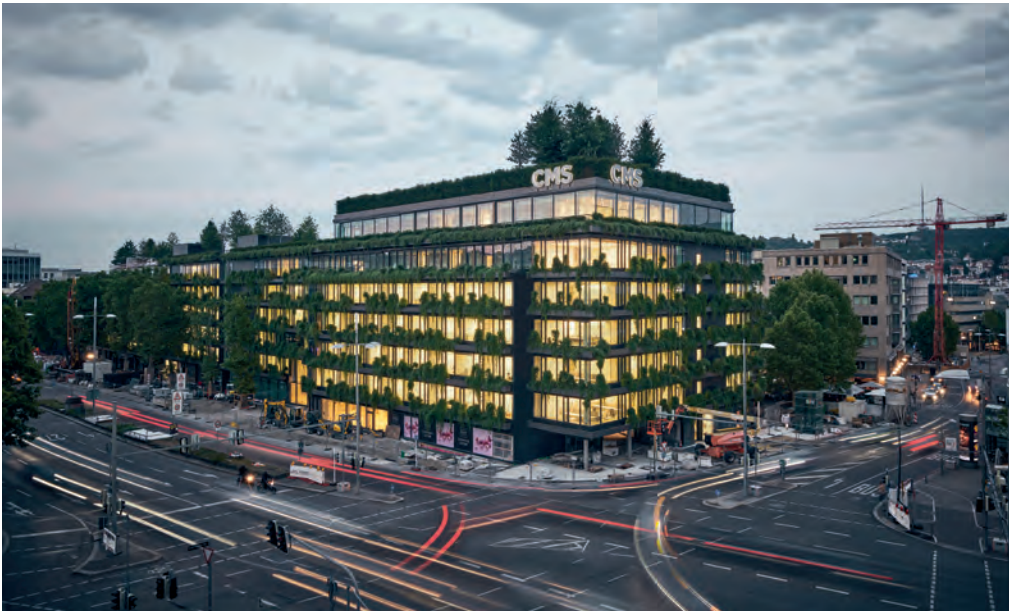
Die begrünter Fassaden und Dächer des Neubaus um die Calwer Passage in Stuttgart von Christoph Ingenhoven hat das Büro von Werner Sobek geplant. Die Pflanzen setzen 90 Prozent der Sonnenenergie, die auf das Gebäude einstrahlt, in Verdunstungskühle um.
