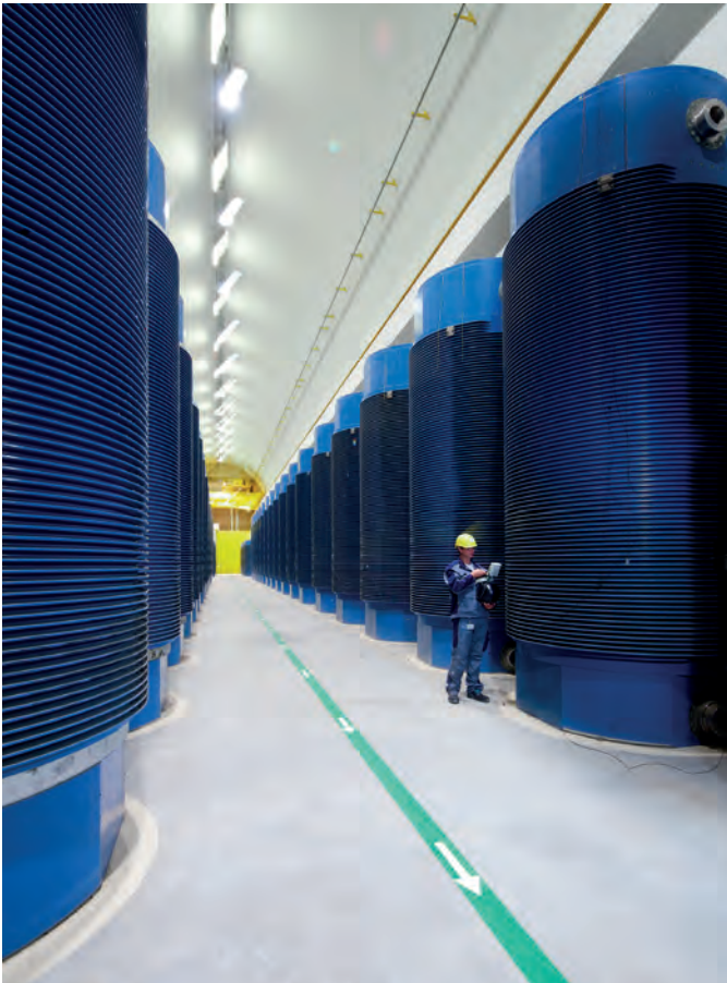
Blick ins Zwischenlager
