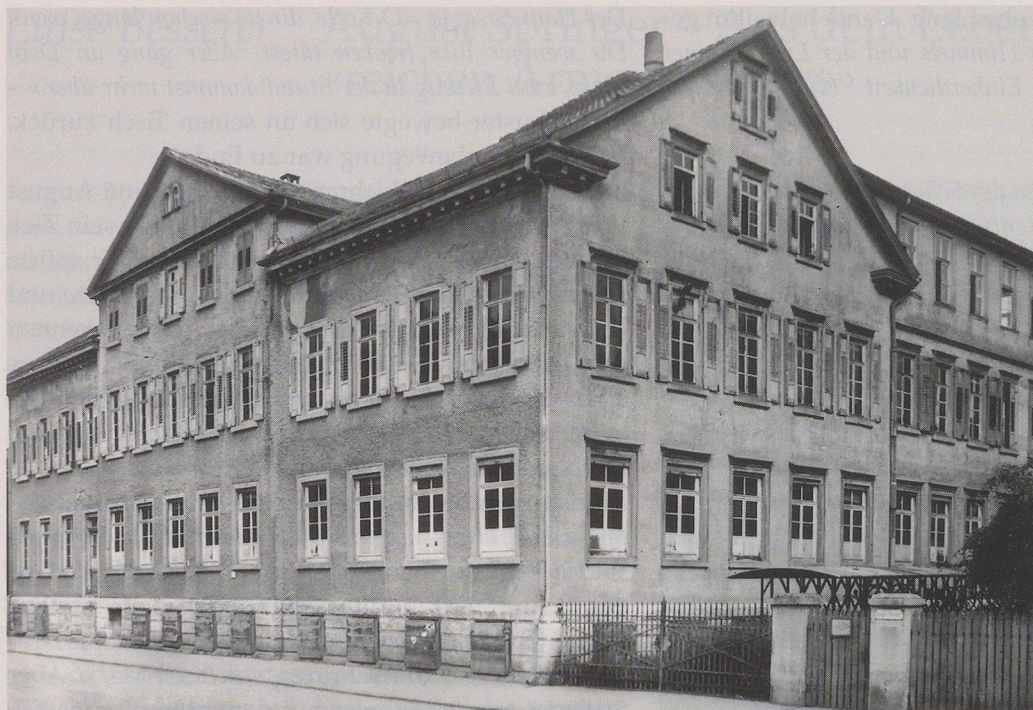
Tuttlingen, Bahnhofstraße 89, Gebäude der Schuhfabrik Gebrüder Henke, später übernommen von der Firma J. G. Martin KG, die gleichfalls Schuhe produzierte.
