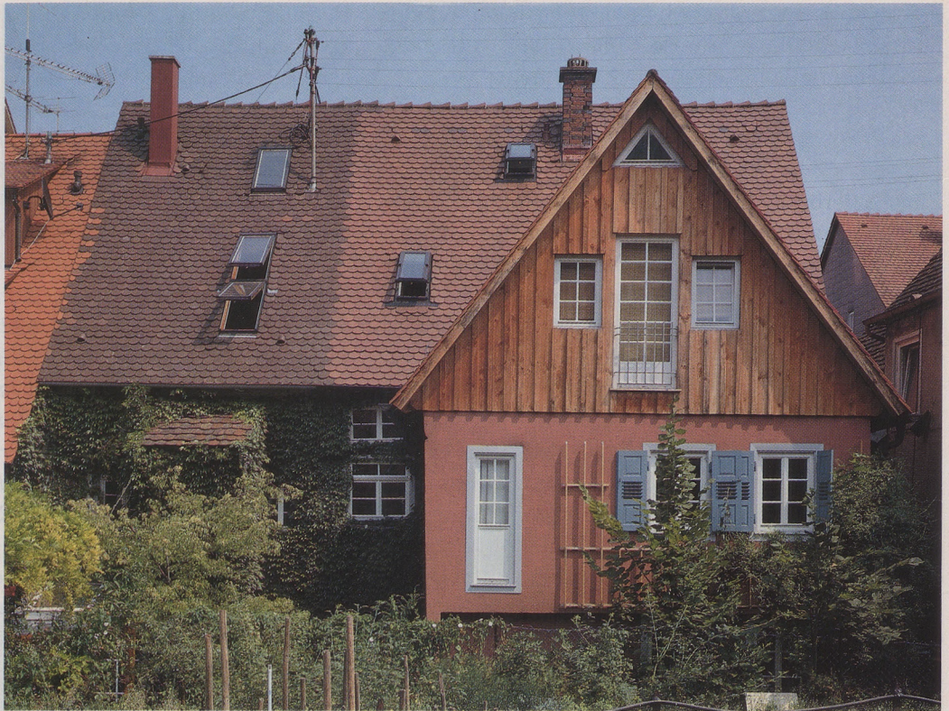
Schwäbisch Hall, das Haus in der Langen Straße 26 von Westen aus gesehen, von der Gartenseite.
