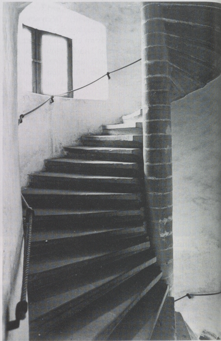
Wendeltreppe im Turm von Schloß Waldburg, das 1991 wieder der Öffentlichkeit zugänglich sein soll.
