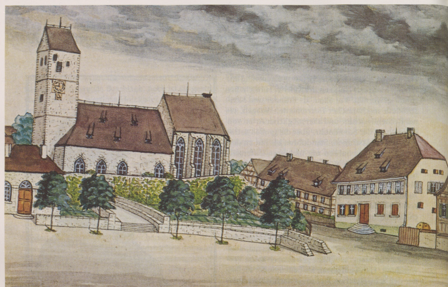
Die evangelische Pfarrkirche Echterdingen mit dem spätmittelalterlichen Chor von 1508/1510 und dem ursprünglichen gotischen Satteldach des Turms, daneben die alte Schule und das stattliche Pfarrhaus mit dem Halbwalmdach, in dem auch Philipp Matthäus Hahn gewohnt, geforscht und amtiert hat. Vor 1866 hat Anton Burk, der Sohn des damaligen Ortspfarrers, dieses farbige Aquarell des Echterdinger Kirchplatzes gemalt.
