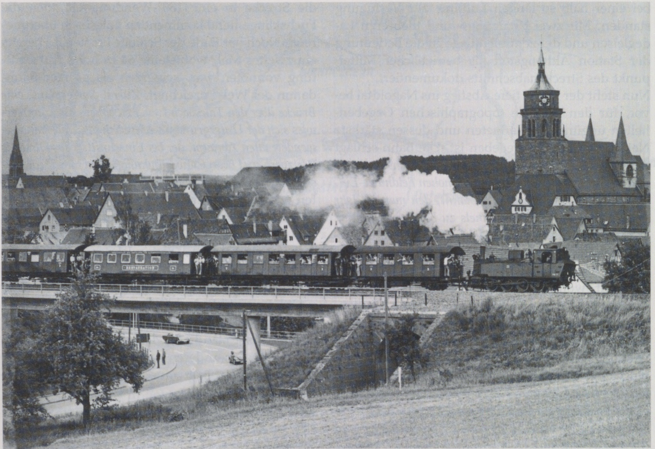
Die Überquerung der B 295 mit moderner Spannbetonbrücke bei der Ausfahrt Weil der Stadt, daneben der alte Durchlaß. Die Silhouette beherrscht St. Peter und Paul. Sonderfahrt der Gesellschaft zur Erhaltung von Schienenfahrzeugen (GES) im August 1974.
