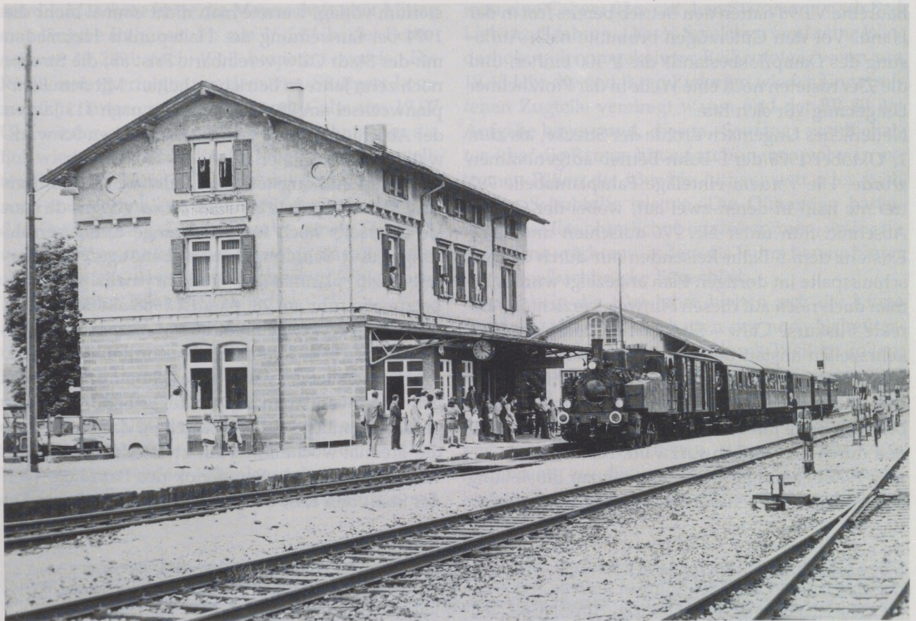
Sonderfahrt im Bahnhof Althengstett, August 1974. All die typischen Details wie das schindelverkleidete Empfangsgebäude, die Holzmastlampe, Bahnsteigabspernung, Stellwerksvorbau mit Uhr und Weichen- und Signalspannwerken rechts sind eine Betrachtung wert. Das meiste davon ist inzwischen verschwunden.
