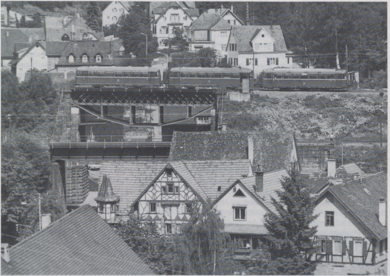
Der «Bienenschuß», der Schienenbus, ist unterwegs: die Calwer Ziegelbachbrücke mit ihrer geschützten Stahlfachwerkkonstruktion, 20 Meter darunter die Stuttgarter Straße und vorne die Blechträgerbrücke der Nagoldbahn.
