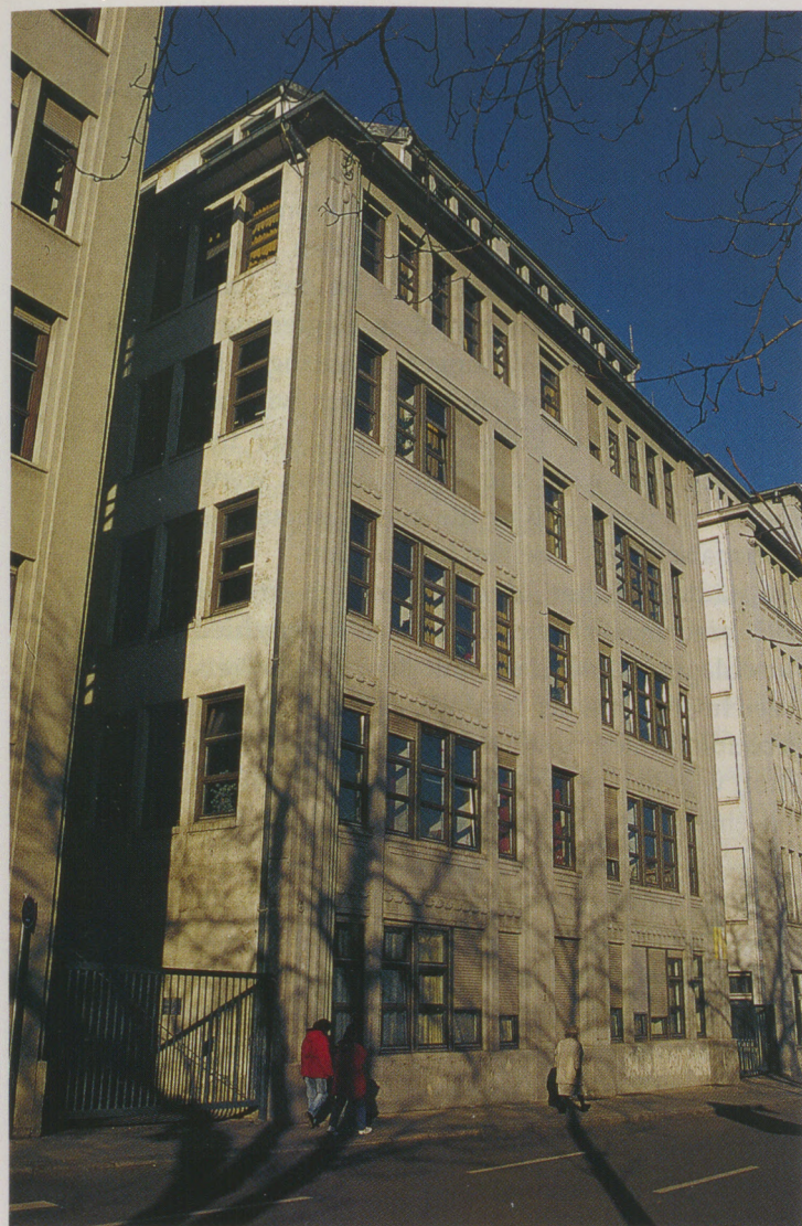
Bau 16 in der Breitscheidstraße 6: einer der ersten mit Sichtbetonfassade.
