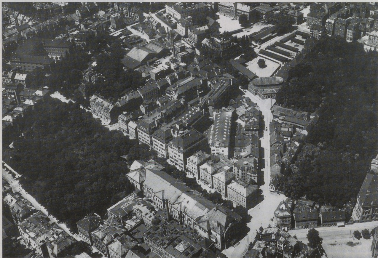
Das Bosch-Areal und Umgebung 1925. Im Vordergrund der langgestreckte Bau der alten Liederhalle, rechts der Hoppenlau-Friedhof und die Reithalle.
