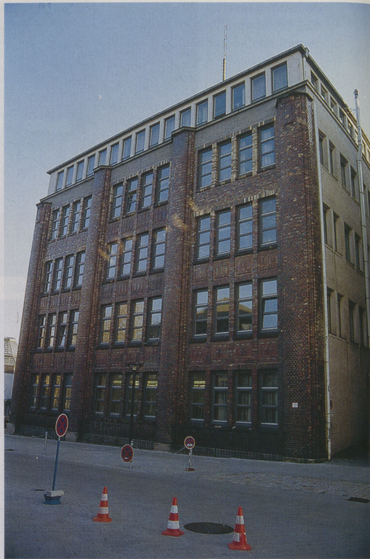
Heutiger Zustand des Gebäudes Forststraße 7, Bau 17.
