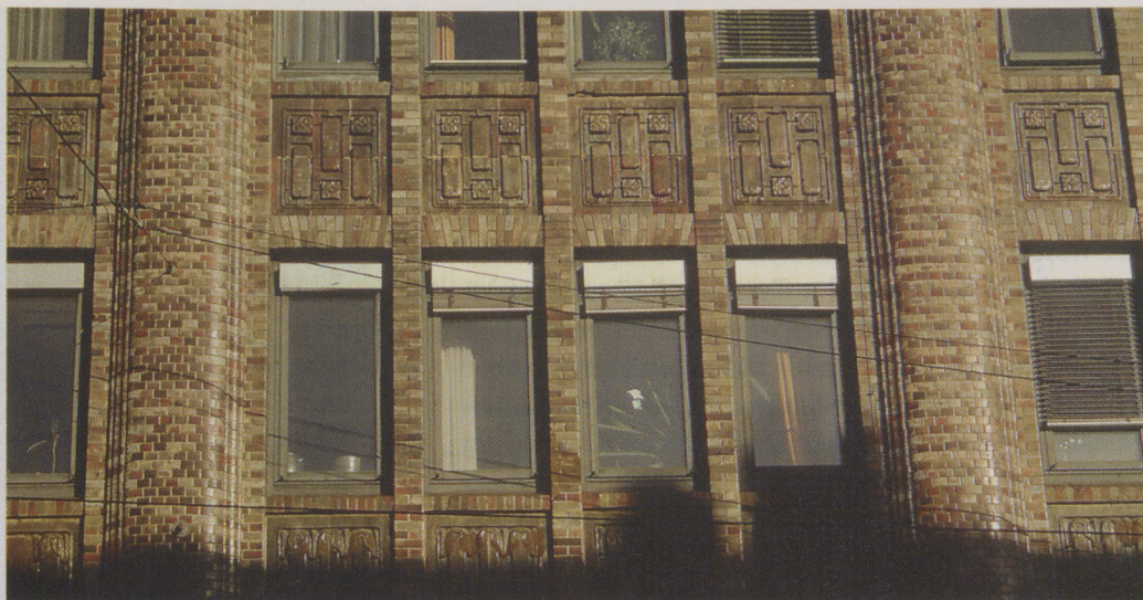
Bau 19, Detail aus der Fassade.
