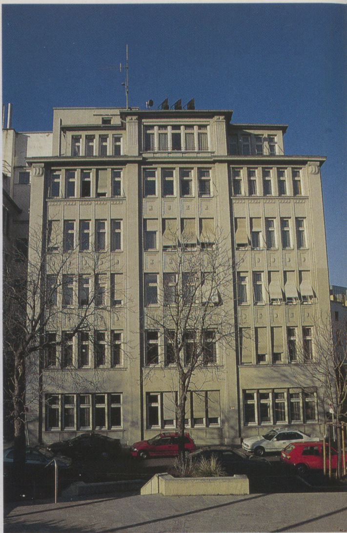
Bau 15, Breitscheidstraße 4: Das ehemalige Verwaltungsgebäude mit Sichtbetonfassade. Es hat sich wie der danebenstehende Bau 16 bis heute kaum verändert.
