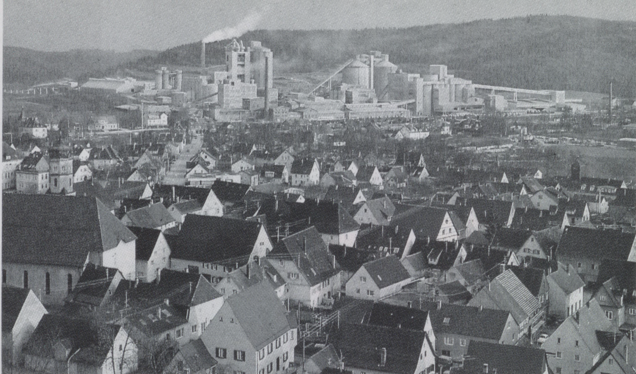
Ansicht des Zementwerkes Schelklingen der Heidelberger Zement AG in unseren Tagen. Sie macht die gewaltige Ausdehnung heutiger Zementwerke gegenüber früheren Produktionsanlagen deutlich. Zwischen 1902 und 1972 steigerte sich die Jahresproduktion des Schelklinger Zementwerkes von 35 000 t auf etwa 1,5 Mio. t.
