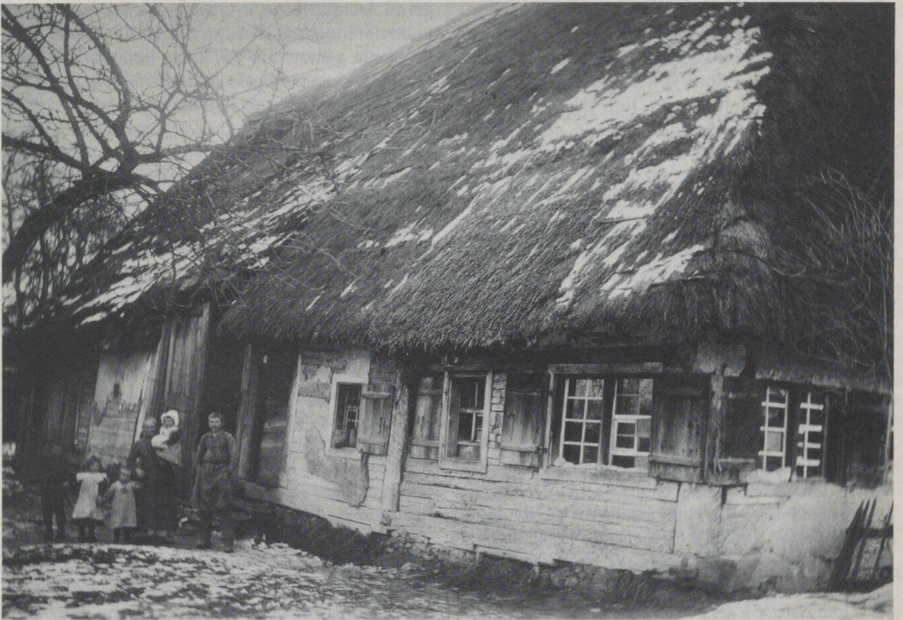
In Kürnbach bei Bad Schussenried hat Max Lohss um 1910 dieses Strohdachhaus aufgenommen, das zwei Jahrzehnte später bereits abgegangen war. Das Vollwalmdach des einstöckigen Mittertennhauses, das wohl im 16. Jahrhundert erbaut wurde, ist noch ein reines Strohdach.
