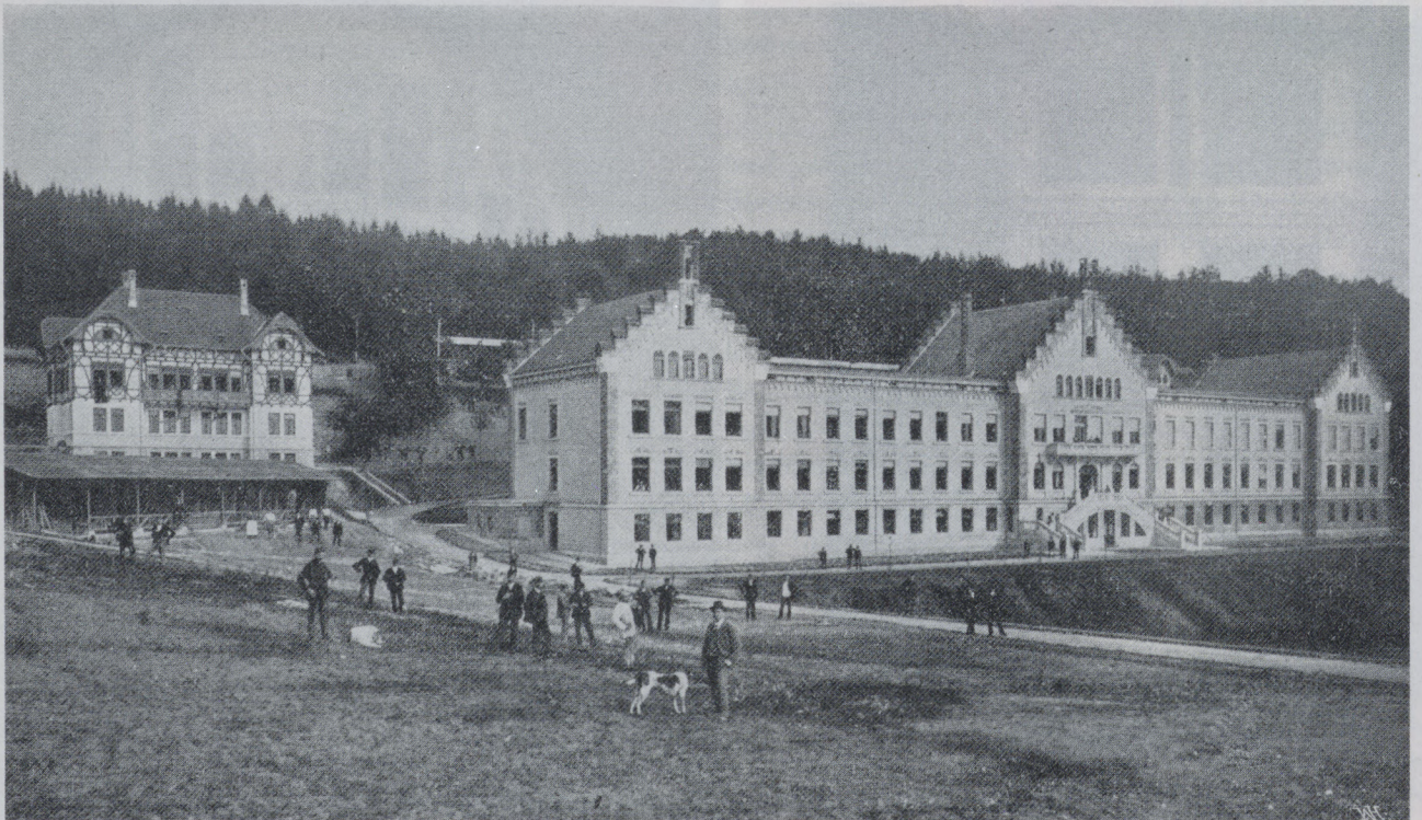
Unten: Lungenheilstätte Wilhelmsheim-Oppenweiler; Abbildung aus der Schrift, die 1900 zur Eröffnung erschienen ist. Links: Arztgebäude und Liegehalle.
