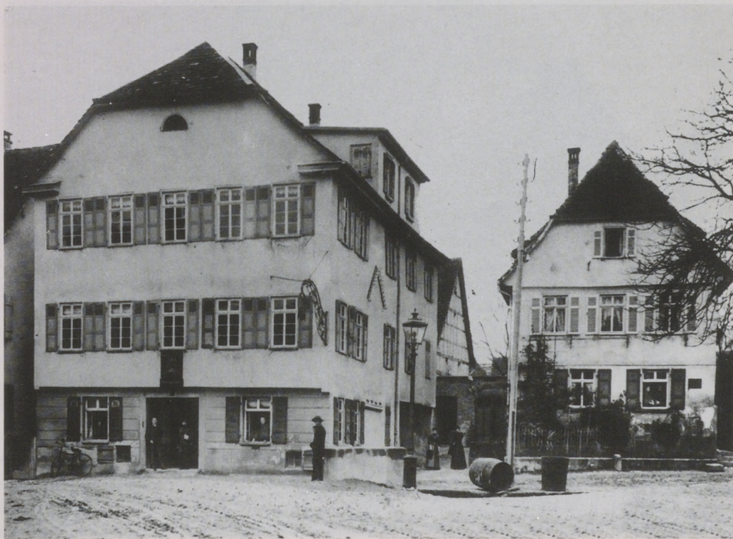
Pfullinger Gasthaus «Zum Lamm» mit Standleuchte und Mast für elektrische Leitungen, aufge- nommen um 1905.
