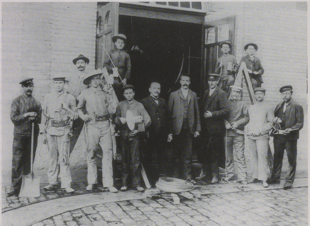
Johannes Rieger – links neben der Kabelrolle am Boden – mit seinen Mitarbeitern vor seinem Pfullinger Elektrizitätswerk.
