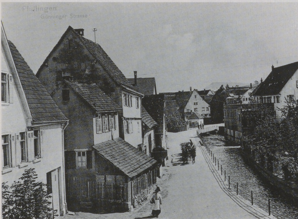
Gönninger Straße in Pfullingen mit Blick auf das Elektrizitätswerk, das rechts im Bild zu sehen ist. Um 1920.
