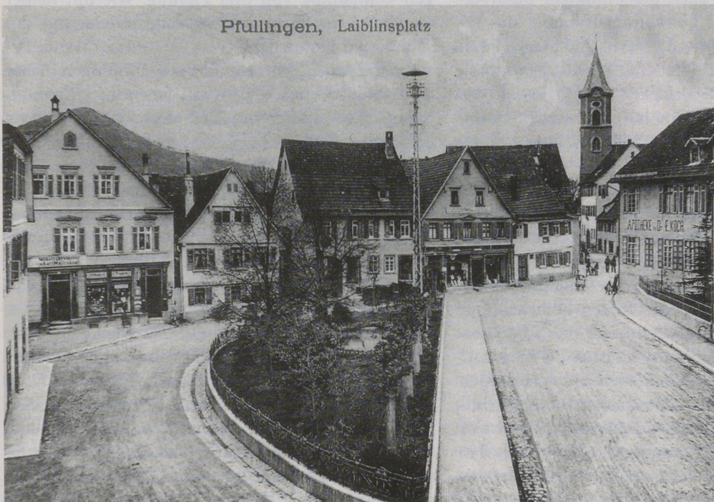
Laiblinplatz in Pfullingen, fotografiert um 1905. In der Mitte ein Gittermast für Freileitungen mit elektrischer Bogenlampe. Im Hintergrund der Turm der Martinskirche.
