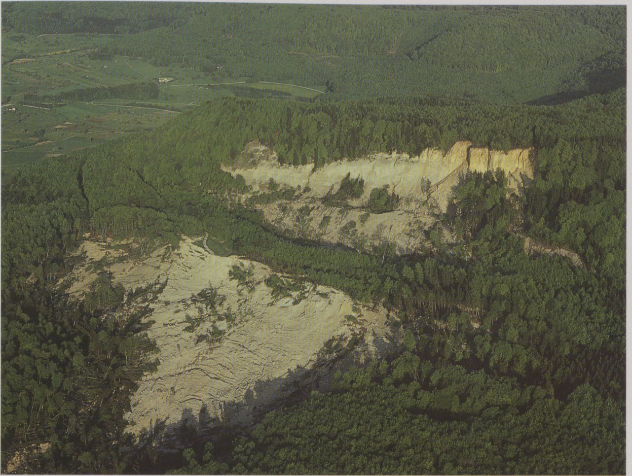
Gesamtansicht des Berggrutsches am Hirschkopf bei Mössingen, fotografiert im Frühjahr 1983 kurz nach dem Ereignis. Oberhalb der Geröllhalde durchzieht ein stehengebliebener Waldstreifen das Rutschgelände. Oben der Abbruchstreifen am Rande der Hochfläche der Schwäbischen Alb.
