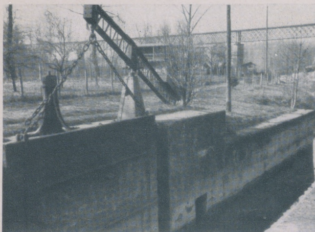
3. Schleuse Marbach, Unterhaupt. Tummelfalle, Tummelbaum, Ausmündung des Umlaufkanals. Aufnahme 1938
