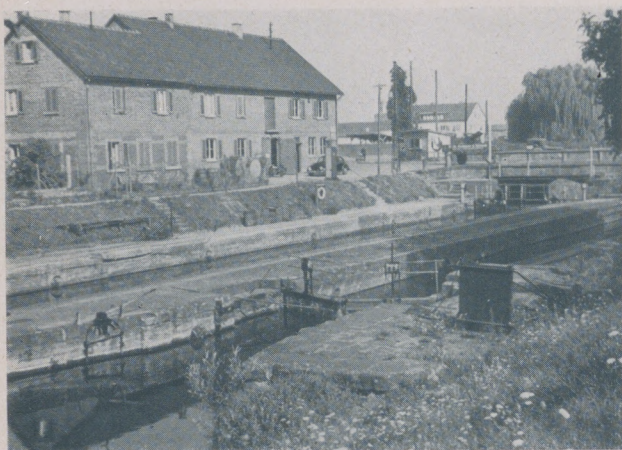
8. Schleusenanlage des Wilhelmskanals in Heilbronn. Vorn die Schleuse von 1821, hinten die von 1884. Aufnahme 1952
