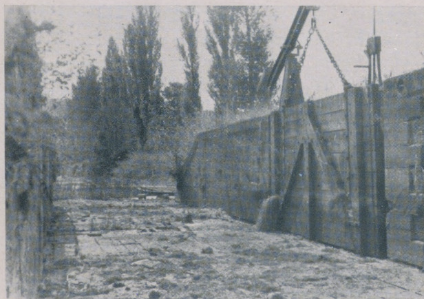
5. Schleuse Hessigheim nach der Trockenlegung 1949 Blick von der Sohle zum Unterhaupt mit der Tummelfalle
