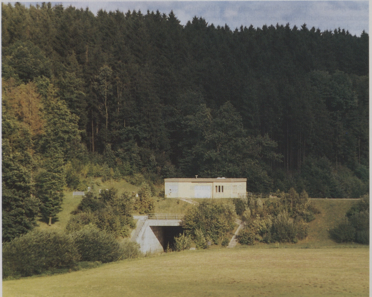
Ein Fremdkörper im oberen Jagsttal: das Auslaufbauwerk des Beckens Buch bei Ellwangen, 1981 errichtet.
