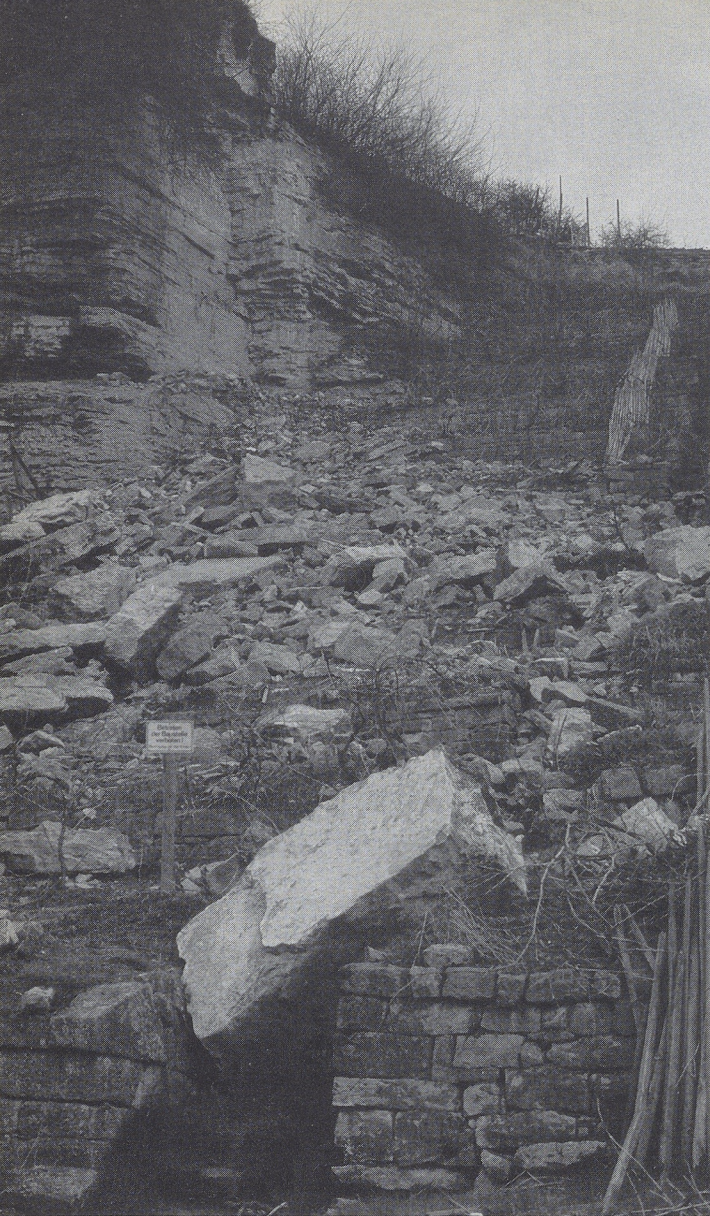
Abbildung 2: Felssturz in den Weinbergen unterhalb von Mühlhausen im Frühjahr 1979
