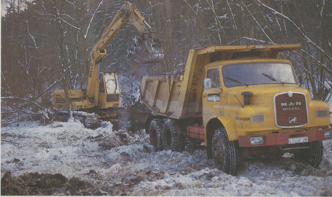
Abbildung 10: Ausbaggerung des Altwassers südlich von Roßweg im Winter 1984/85 bei fast 20 Minusgra- den. Beste Voraus- setzungen für die möglichste Scho- nung der empfind- lichen Feucht- gebietsvegetation.
