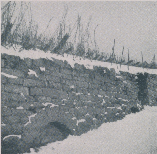
Weinbergmauern in Bruchstein-Trockenmauern und in Zement
