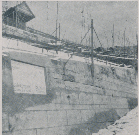
Weinbergmauern in Bruchstein-Trockenmauern und in Zement
