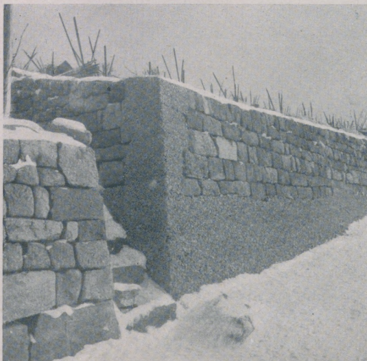
Weinbergmauern mit Beton und Zement in den Untertürkheimer Weinbergen
