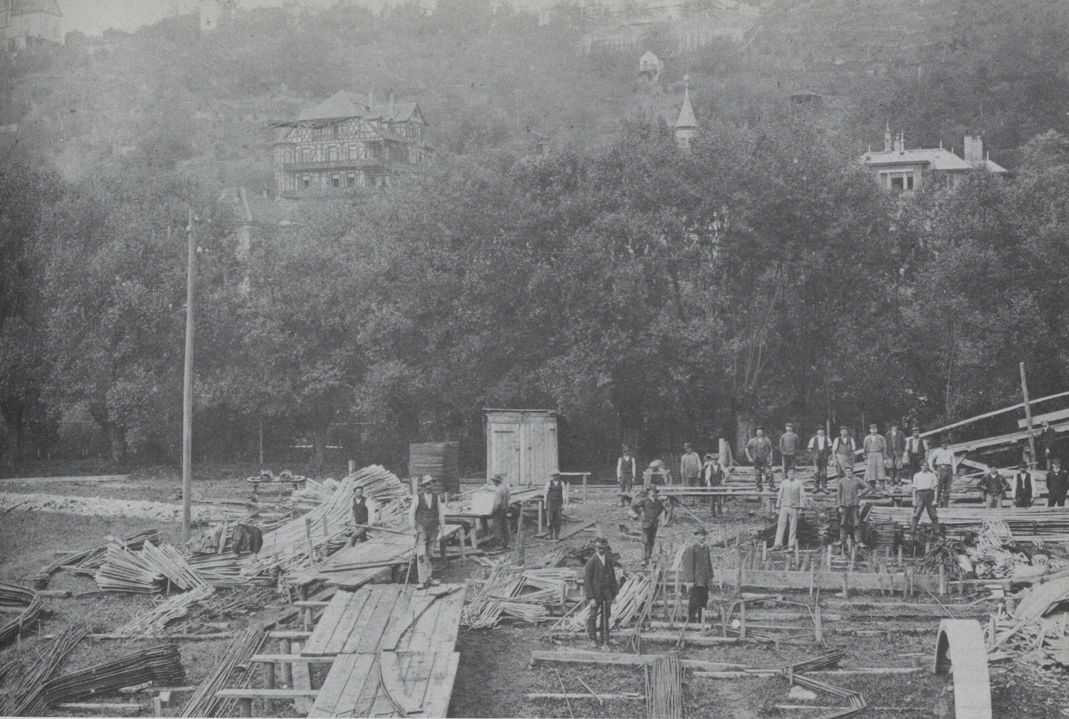
Bau der Bahnstrecke Tübingen–Herrenberg: der Bau der Eisenbetonbrücke und des Tunnels durch den Tübinger Schloßberg erfordern einen großen Werkplatz mit Eisenstangen und Verschalungsmaterial (oben) und auch eine transportable Feldschmiede (unten).
