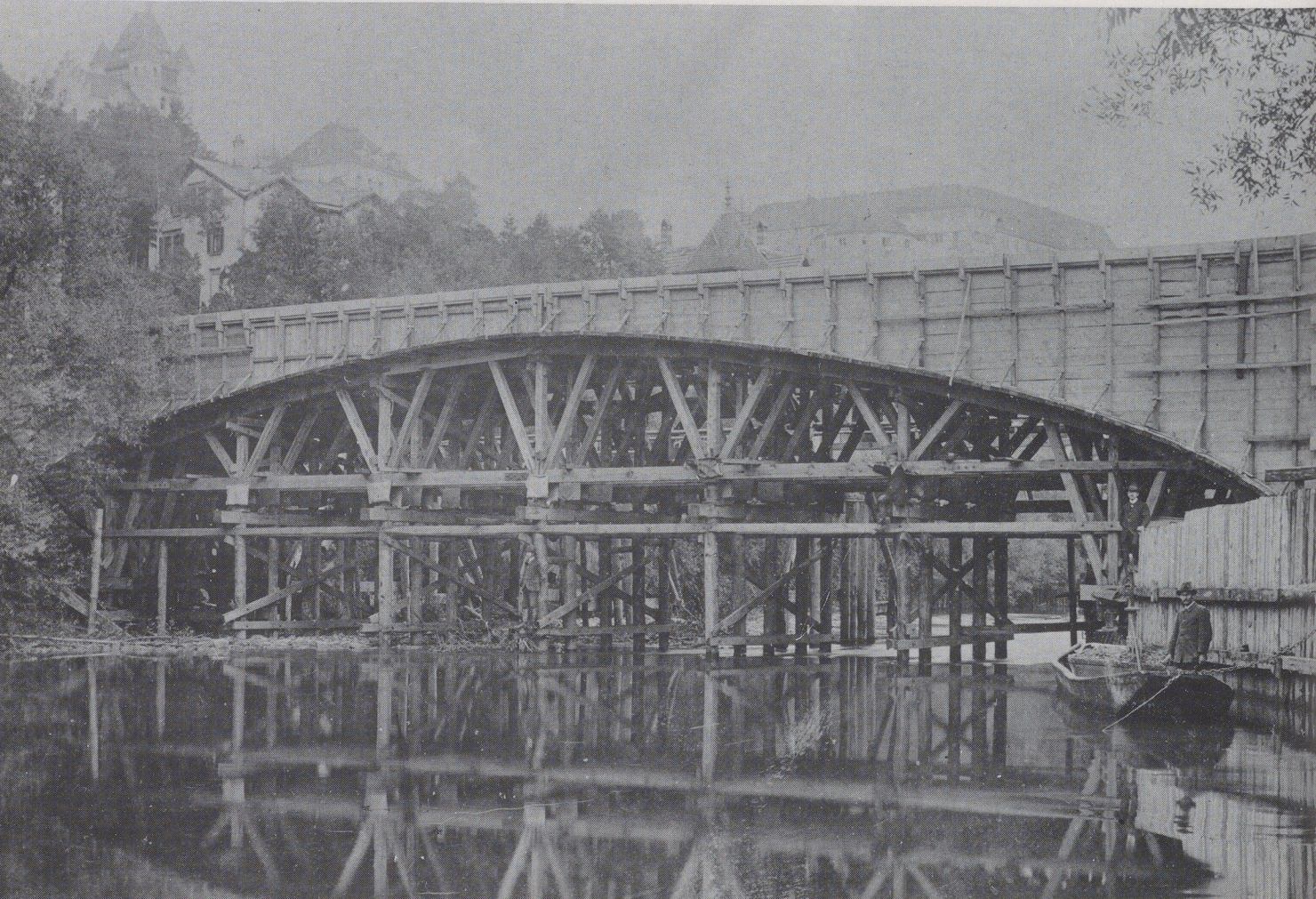
Eisenbahnbrücke über den Neckar und Tübinger Schloß: Tradition und Fortschritt um 1910. Das Bild unten gibt einen Eindruck von der hölzernen Verschalung der Brückenbögen, bevor der Beton in das Eisengeflecht gegossen wurde.
