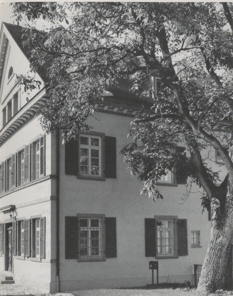
Ehingen, Lindenstraße 60: Anblick von Norden her nach der Renovierung.
