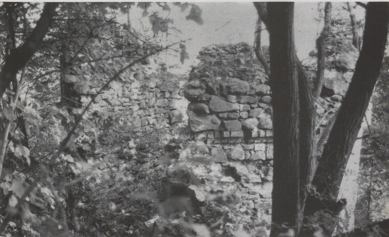
Heutiger Zustand der Burg Ratzenried: Links oben Turm (Grundriß Nr. 22) mit der Ringmauer der Hauptburg; die Schießscharten sind ausgebrochen. Der Turm in der Mitte oben (Nr. 21) ist am baufälligsten; bis zur Hälfte der Mauerdicke sind bereits die Steine herausgebrochen. Hier beginnt die geplante Sanierung. Oben rechts: Turm Nr. 22 von Süden her; Tannen wachsen auf dem Mauerkranz. Das Bild unten verdeutlicht, wie sehr Wald, Gebüsch und Gestrüpp die Mauerreste überwuchern.
