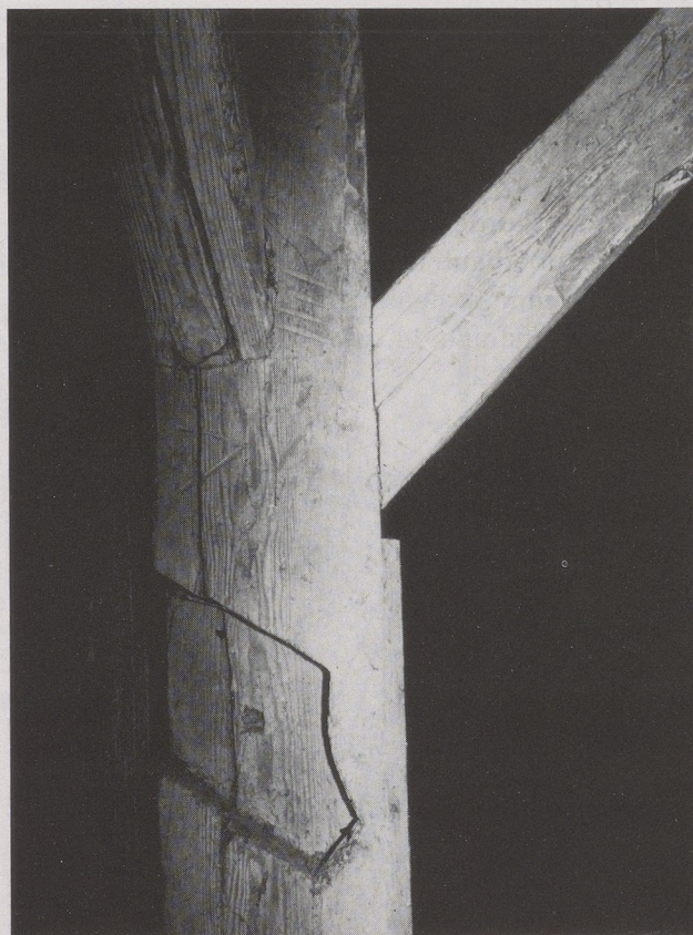
Oberdorfstraße 12, 's Weinbrenners: «Liegende Stühle» bilden in allen Häusern des Schwenninger Oberdorfs das Tragegerüst für Sparren und Schindelbedachung. Unten links: Ob dem Brückle 14, 's Diisen: Sogar die Angelpfannen für die Aufhängung des Scheuertors sind aus Holz, hier Hartholz, gefertigt. Unten rechts: Die Säule im Schützenbuurenhaus, Oberdorfstraße 8, zeigt deutlich die Verblattung, die vor der Verzapfung üblich war.
