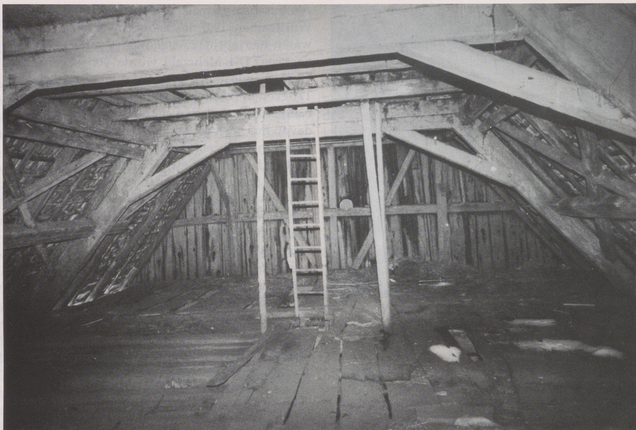
Oberdorfstraße 12, 's Weinbrenners: «Liegende Stühle» bilden in allen Häusern des Schwenninger Oberdorfs das Tragegerüst für Sparren und Schindelbedachung. Unten links: Ob dem Brückle 14, 's Diisen: Sogar die Angelpfannen für die Aufhängung des Scheuertors sind aus Holz, hier Hartholz, gefertigt. Unten rechts: Die Säule im Schützenbuurenhaus, Oberdorfstraße 8, zeigt deutlich die Verblattung, die vor der Verzapfung üblich war.
