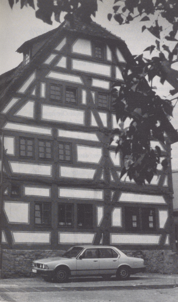
Die renovierte Südfassade zeigt eine schöne alemannische Fachwerk-Konstruktion.
