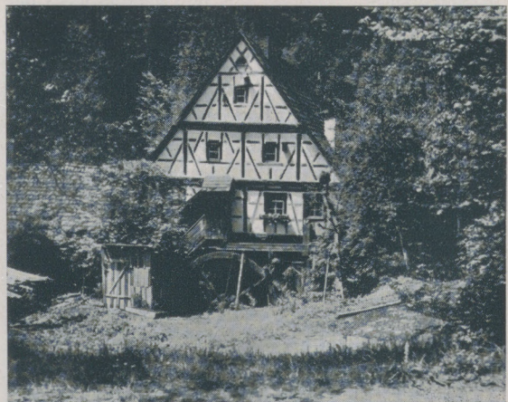
Götzenmühle bei Lorch. Weit gestellte Ständer, Streben in Form des ganzen und halben „Mannes“
