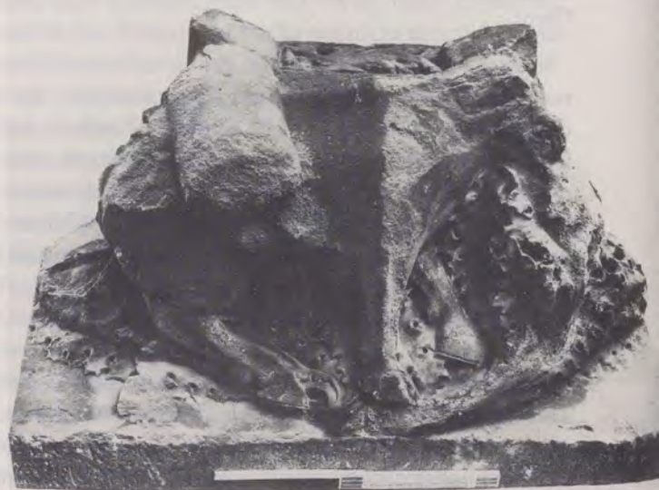
Freiburger Münster. Links der Gipsabguß von 1900 der Konsole von 1250, rechts der Zustand der Konsole am 1. Februar 1982.
